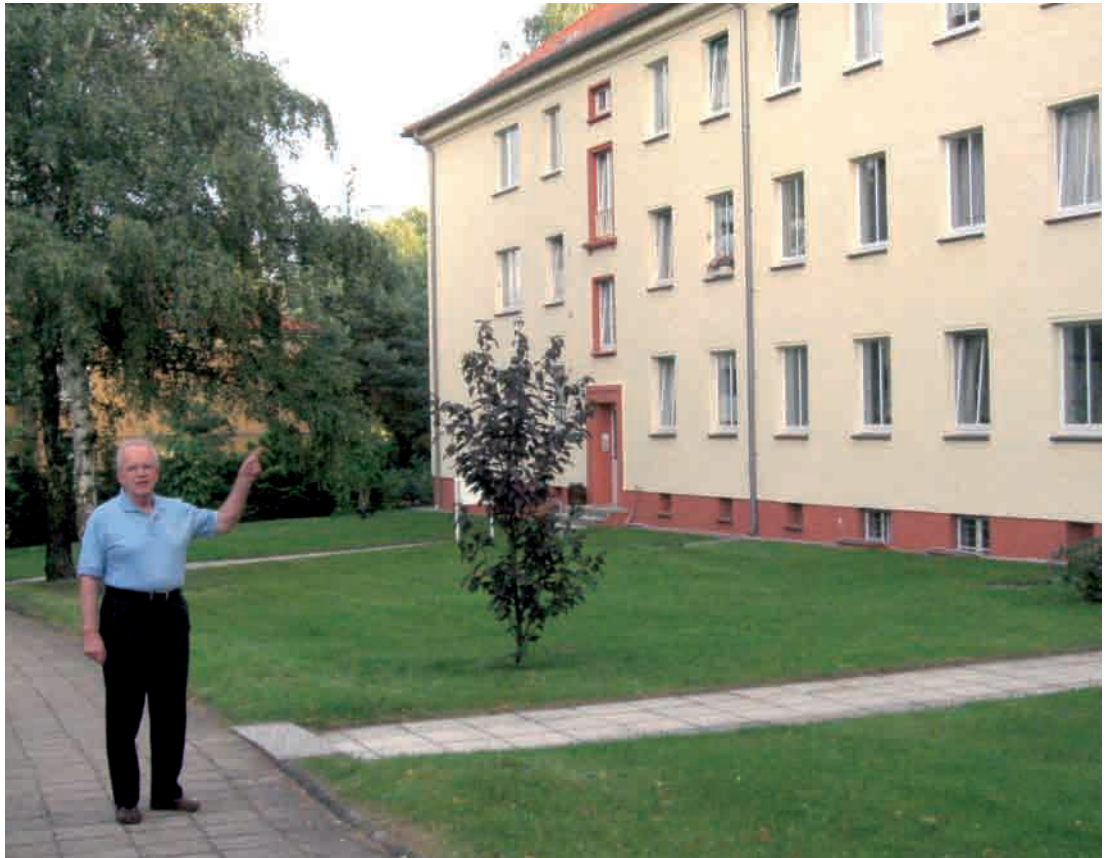
Der Lehrlingsbau hat die Jahre gut überstanden.
